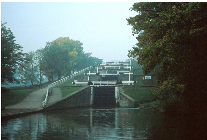
Les écluses de Bingley Five Rise Locks par l'aval
