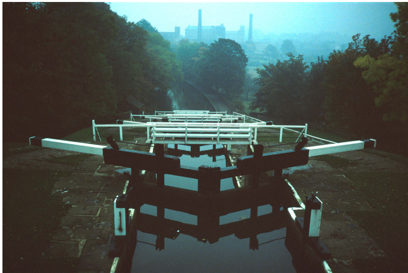
Les écluses de Bingley Five Rise Locks par l'amont
